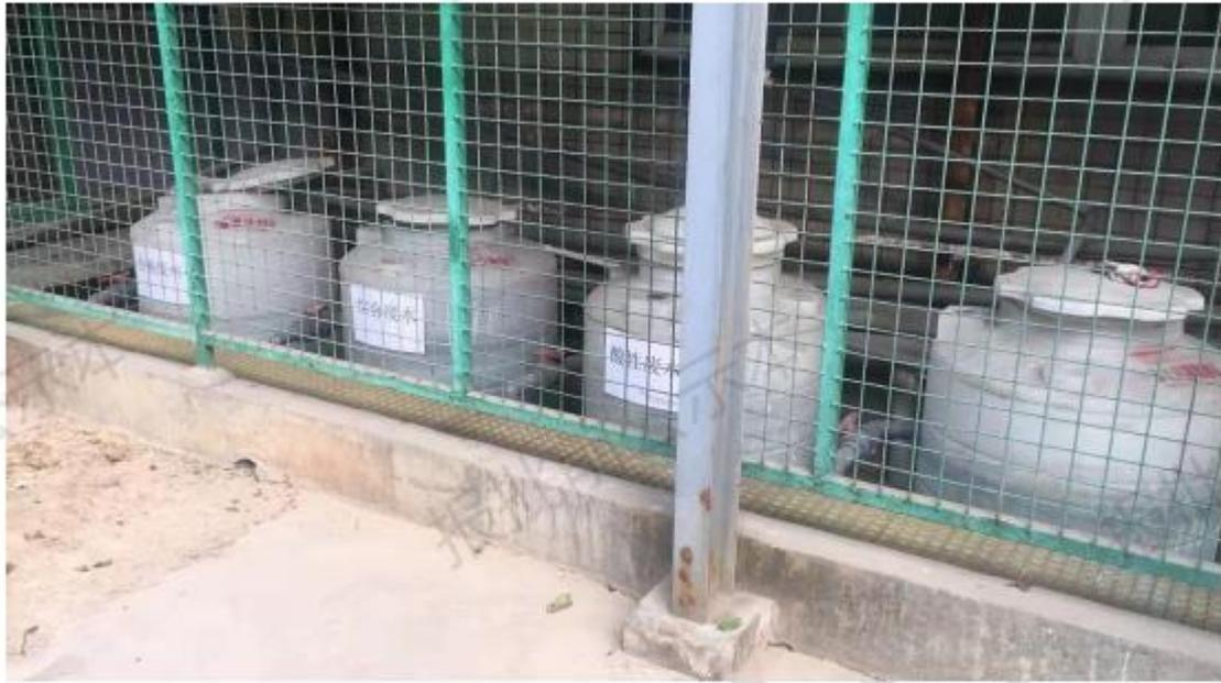
图 7.1-2 废水分类收集罐照片
